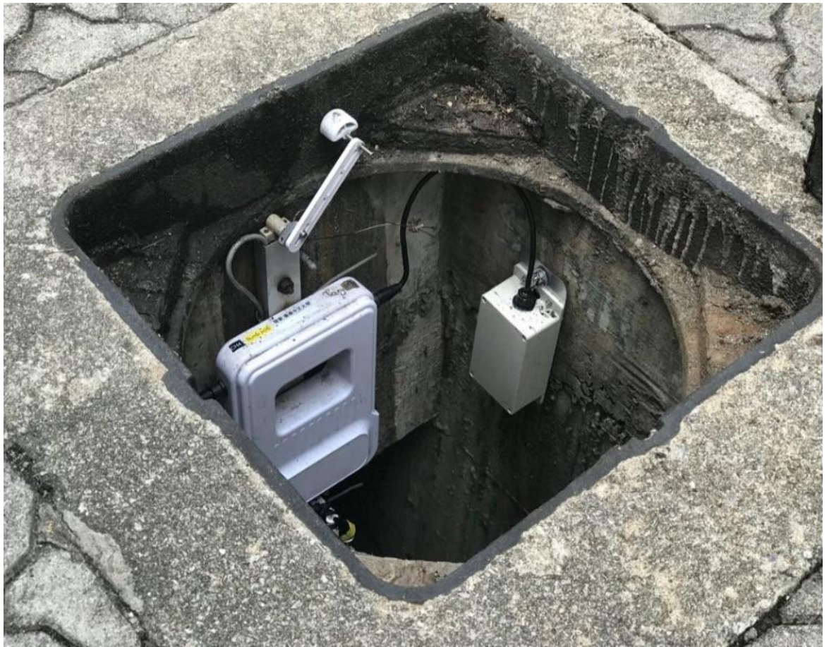
Рисунок 1.3 Тип размещения датчиков на люк.
